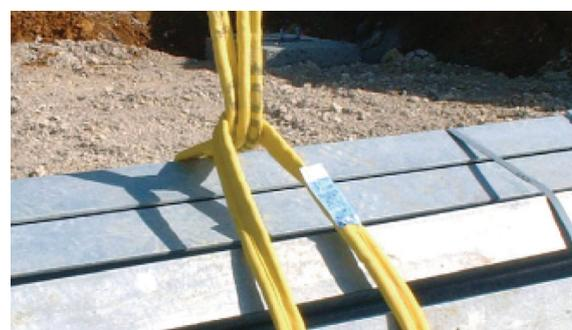
Recommandée pour levage charpentes métalliques
